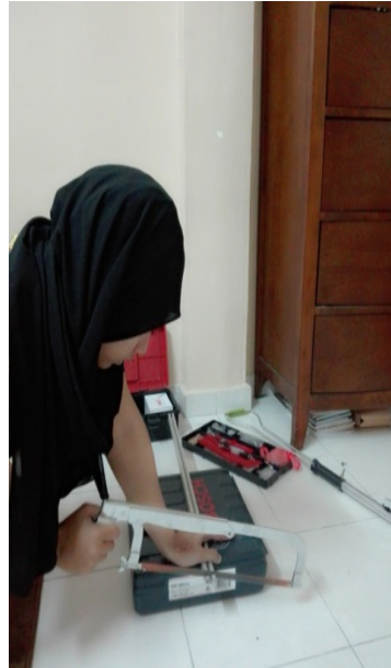
Mengukur dan memotong rail seperti jarak panjang yang dikehendaki
