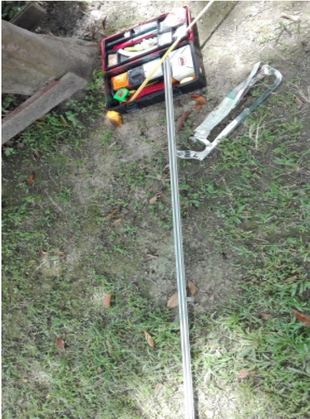
Mengukur dan memotong rail seperti jarak panjang yang dikehendaki
