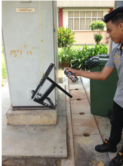
Rajah 3: Proses menyembur cat pada SSC
